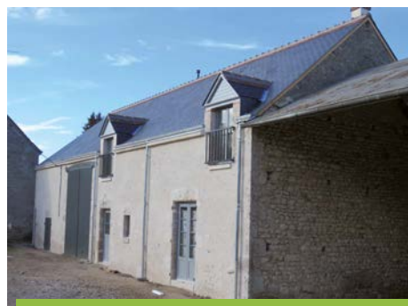
Réhabilitation d'un logement - Tripleville
