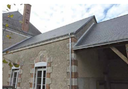
Membrolles : réfection de la toiture de la mairie
