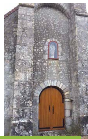
Remplacement des portes de l'église - Semerville
