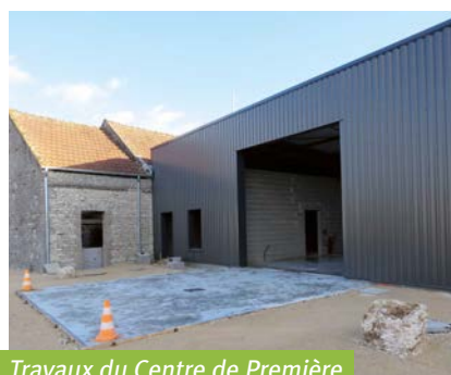
Travaux du Centre de Première Intervention - Verdes
